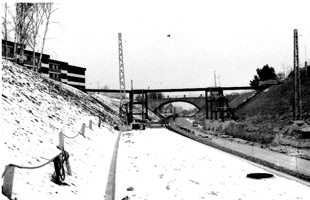
Ny station under anlæg, set mod broen for Emdrupvej 14-3-1976
