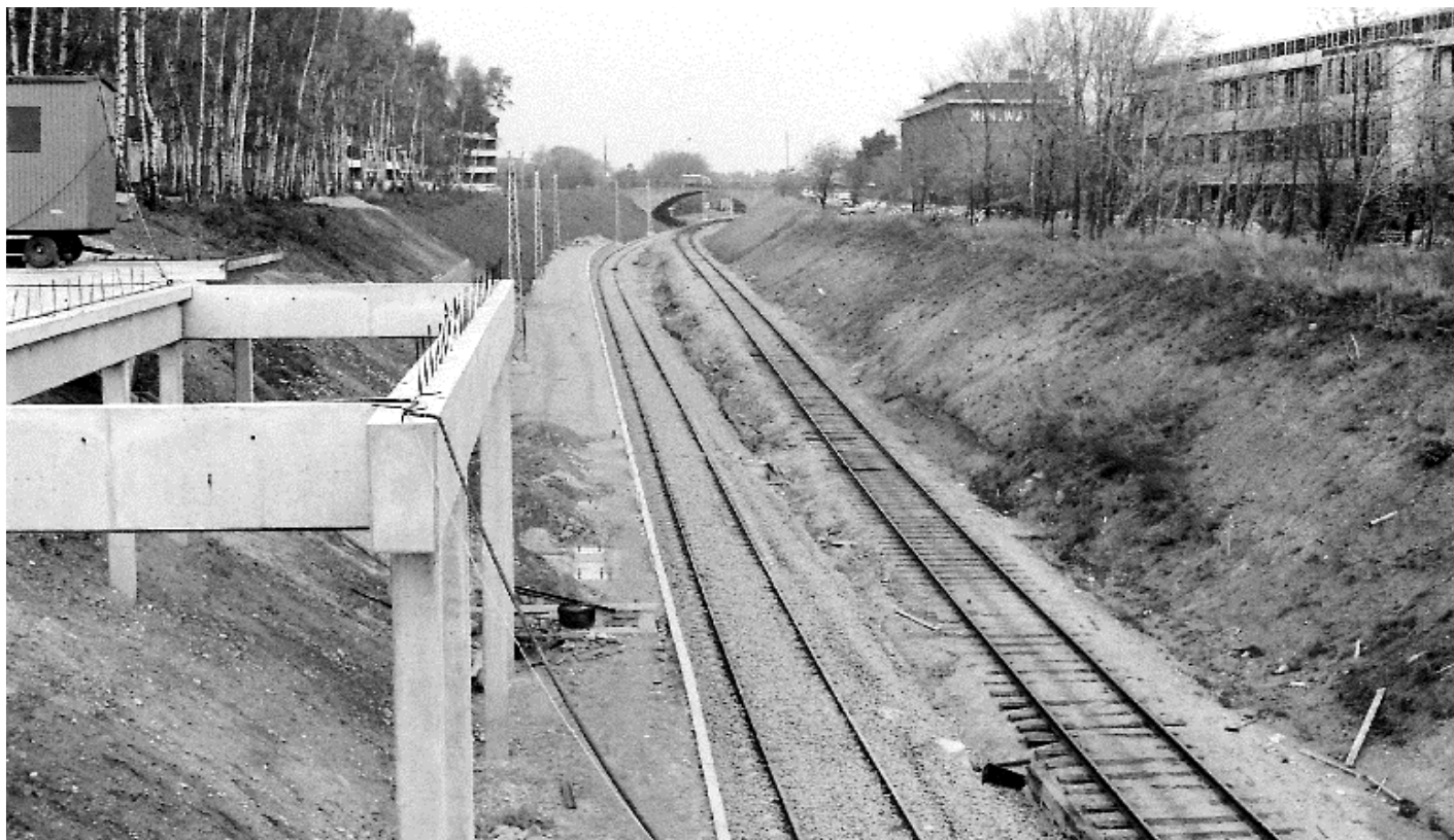
Perronarbejde ved ny station. 3-11-1975
